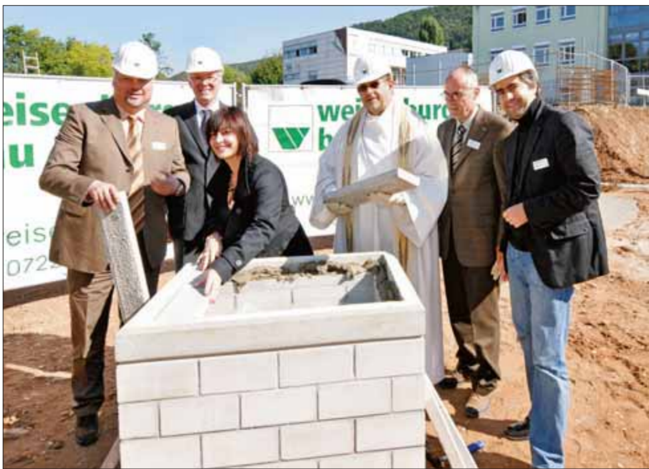
Familienheim-Geschäftsführer Peter Stammer, Stephan Ruck von der Baufirma Weisenburger, Elke Schwarz, Pfarrer Christof Heimpel, Sozialstations-Vorstand Gerhard Moeller und Architekt Björn Burger bei der Grundsteinlegung. Foto: Hentschel
