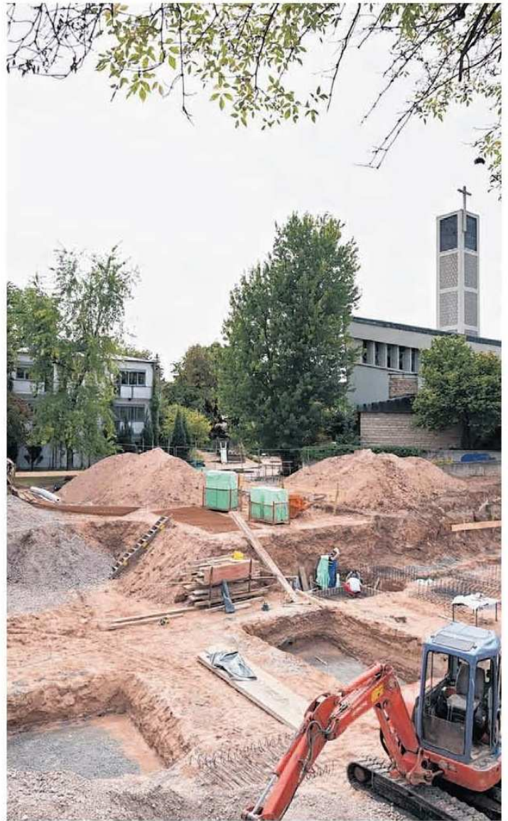
Auf dem Platz der katholischen Kirche St. Michael im Süden der Stadt entsteht das neue Sozialzentrum. BILD: ROTHE
